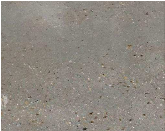
Paviment de formigó amb acabat Lliscat i envernissat
